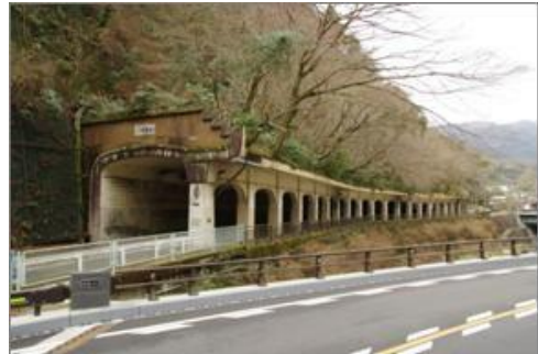
震災後に整備された函嶺洞門
