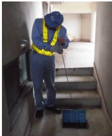
水道メーター付近漏水調査
