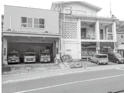
老朽化が進んだ建て替え予定の湯本分署
