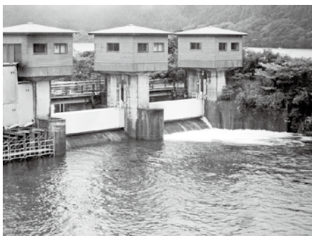
早川に放水中の湖尻水門
