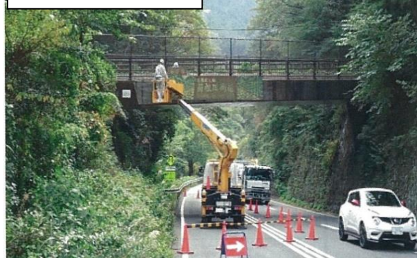
石畳橋の橋梁点検
