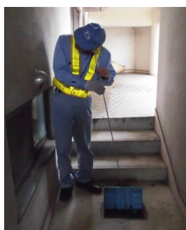
水道メーター付近漏水調査
