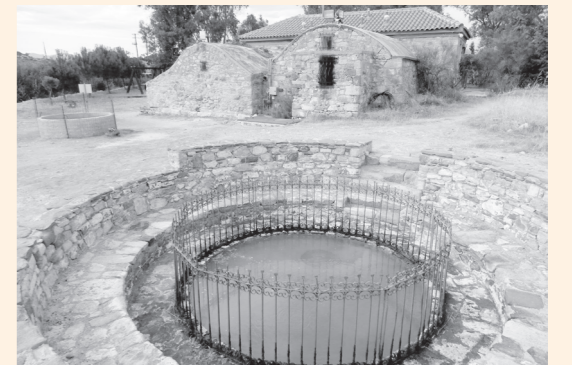
写真1 ギリシア、レスボス島ユネスコ世界ジオパークのポリクニトス温泉の源泉井と湯室の建屋
