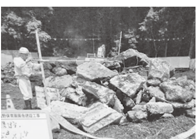
宮城野保育園建設現場
