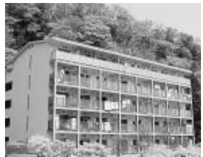
第2上河原町営住宅
